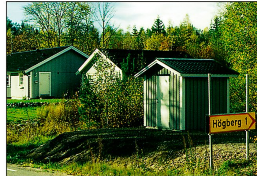
Pumpstation som smälter in i omgivande miljö.
